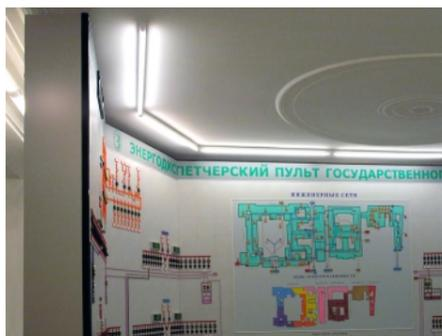
Контурная люминесцентная система подсветки с плавно регулируемой яркостью обеспечивает наиболее равномерное и комфортное освещение щита
