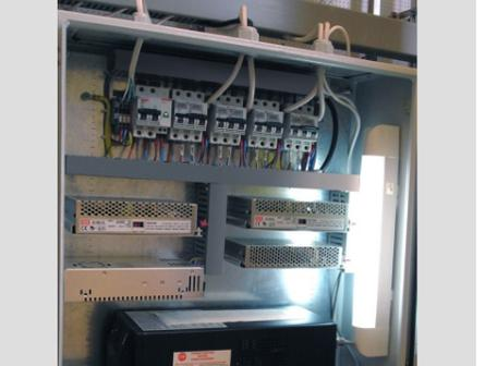
Резервирование питания щита: ИБП в каждом шкафу питания + система "горячего" резерва (по заказу)
