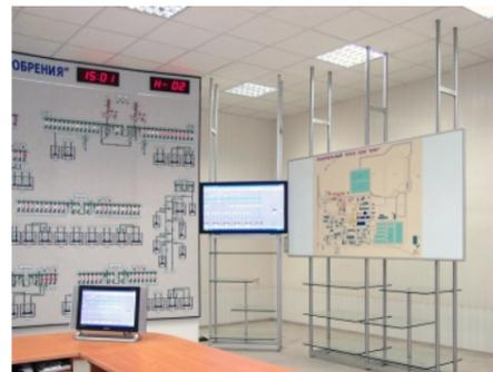
Комплексное решение: активные мнемощит со схемой электроснабжения (пластиковая аппликация) и планшет с генпланом завода (пленочная аппликация) плюс ЖК-панель 46", - все управляется из программы ZNZ32
