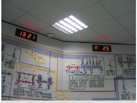
Электронные часы и двухканальный индикатор температуры из серии Ин100, помещенные на фриз щита. Высота символов 100 мм, управление по интерфейсу RS-485. Часы могут быть самостоятельным прибором, а могут быть индикатором компьютерного времени. Возможна GPS-коррекция времени
