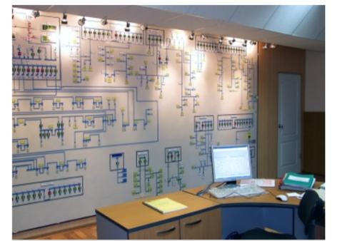
По желанию заказчика щит может стать еще и частью интерьера, например, выступая в роли стены, разделяющей помещение на две части. Нерабочие поверхности щита выполнены в едином стиле с отделкой помещения, сбоку от наборного поля установлена дверь
