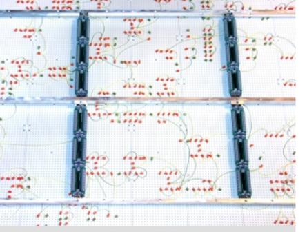
Вид наборного поля сзади. Для установки активных мнемосимволов и индикаторов телеизмерений доступны все 100% наборного поля щита, так называемые "мертвые зоны" отсутствуют
