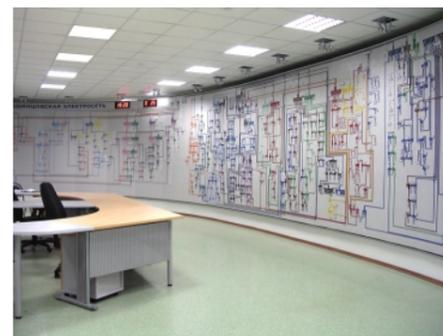
В плане щит может быть расположен по прямой или по ломаной линии, по дуге окружности или эллипса
