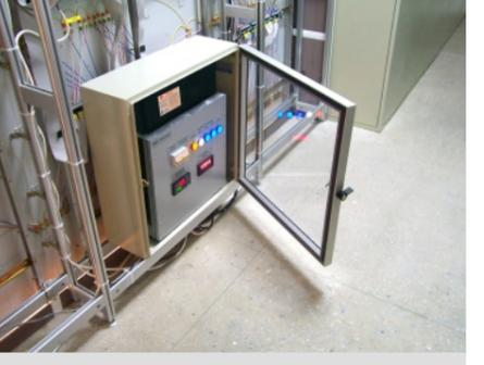
Все цепи опасных для жизни номиналов напряжения (~220В) сосредоточены в закрытых шкафах. Шкафы размещаются вне щита, в исключительных случаях - в пределах щита. Открытый доступ - только к напряжениям 24 В и ниже
