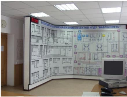
Напольный щит с технологическим коридором между щитом и стеной. Обслуживание системы управления - сзади
