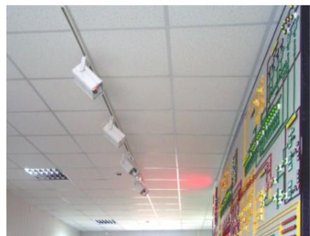
Шинная система подсветки. Шина, закрепленная на потолке, служит токопроводом. Светильники с мощными галогенными лампами могут перемещаться вдоль шины и поворачиваться в двух плоскостях
