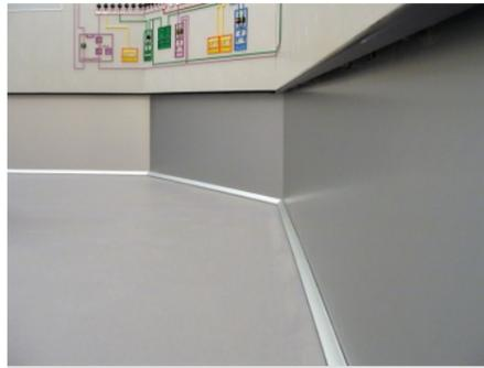
"Дорогие" отделочные материалы. Композитные декоративные панели с алюминиевой поверхностью, окрашенной краской "металлик", на фризе, цоколе и торцах щита, алюминиевый плинтус, алюминиевое обрамление рабочего поля
