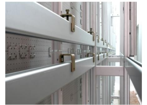
Прочный и легкий каркас щита выполнен из анодированного алюминиевого профиля. Собирается/разбирается за несколько часов благодаря использованию быстродействующих замков. Обеспечивает хорошую жесткость и правильную геометрию конструкции щита
